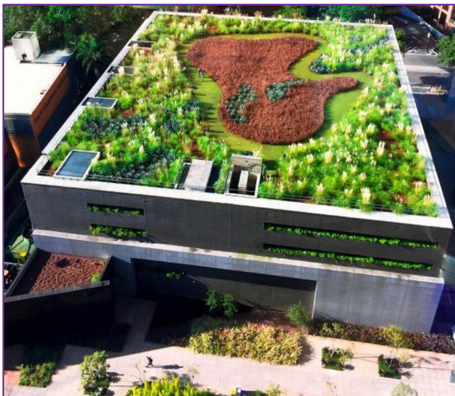
Obrázek 4-1: Zelená střecha na kancelářské budově (Mgr. Josef Nerušil 2014)
